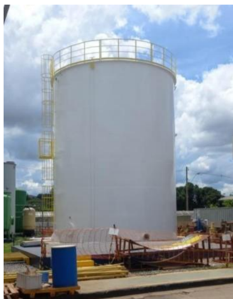
Reservatório Metálico Vertical – In loco com Divisão por Luvas
